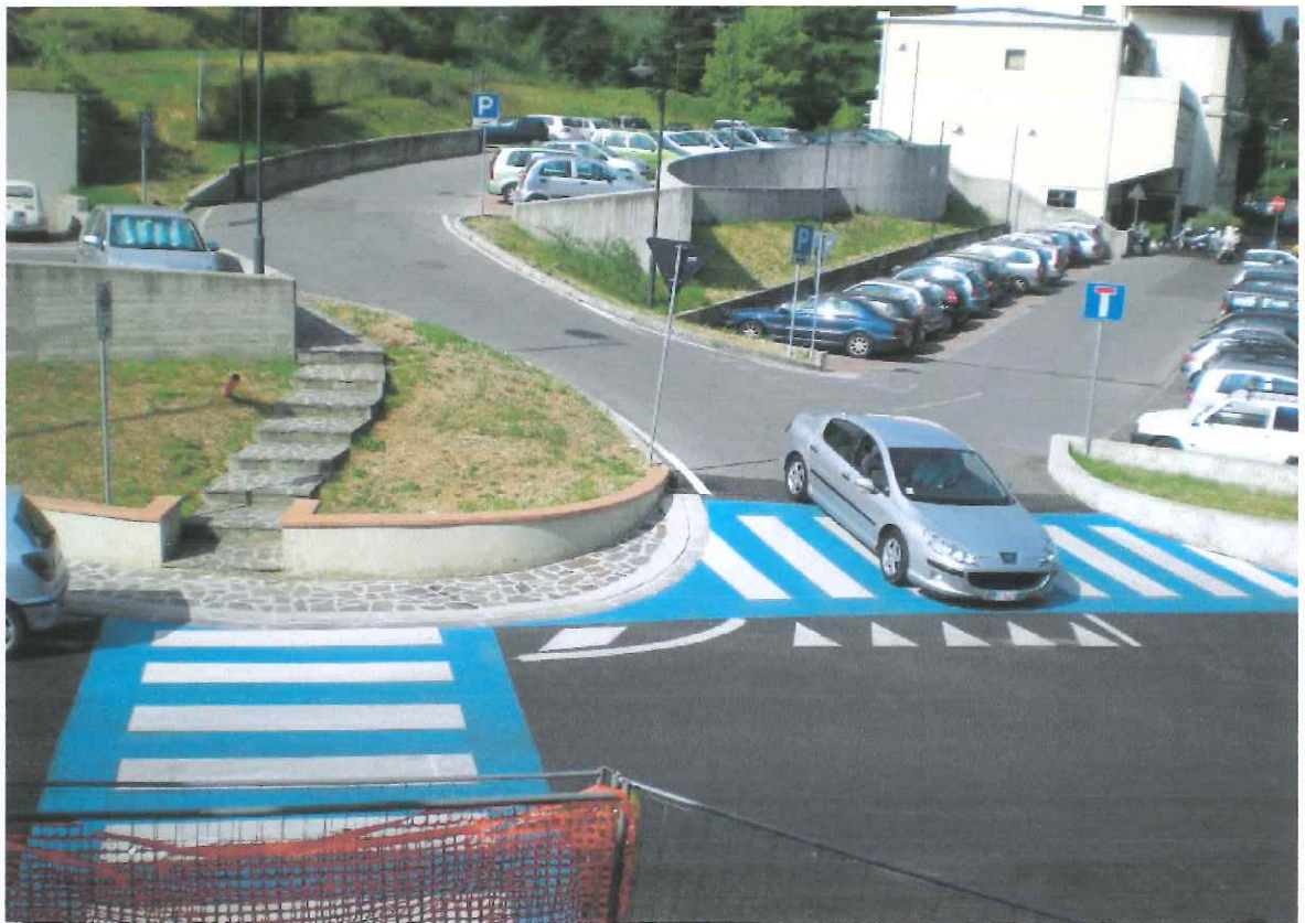
DOCUMENTAZIONE FOTOGRAFICA DELLO STATO ATTUALE DEL CANTIERE
